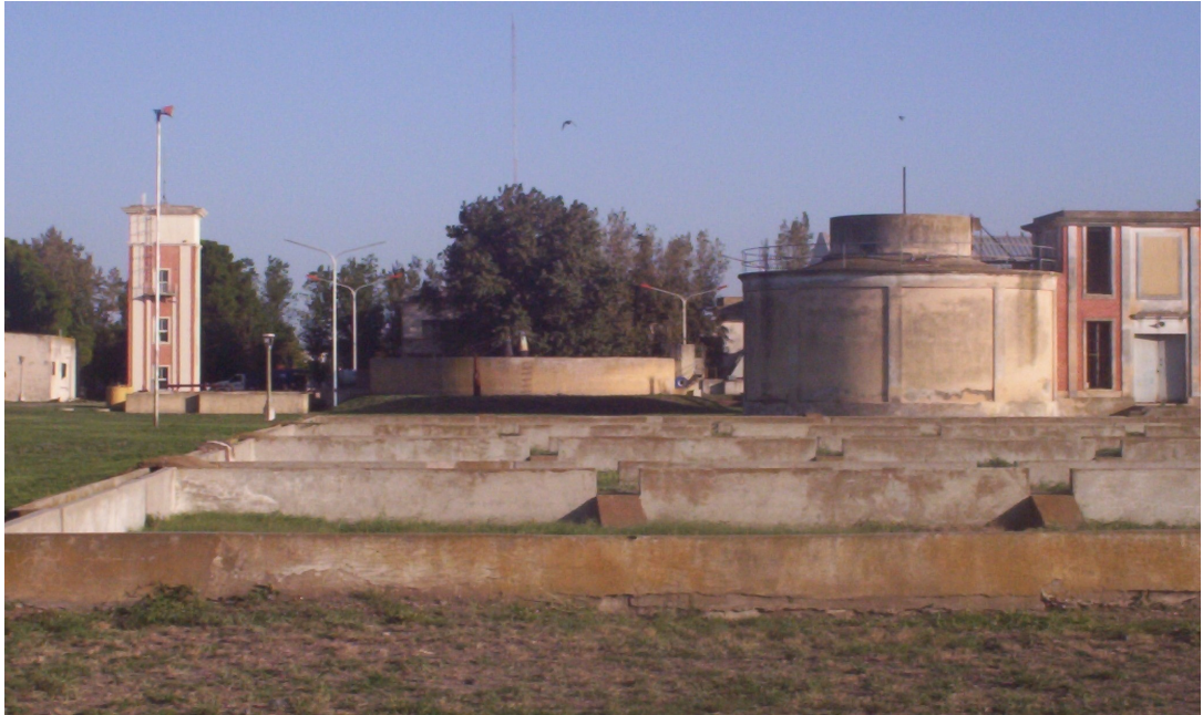
Planta depuradora de residuos cloacales (Dorrego esquina Belgrano)
